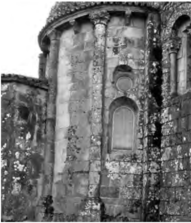
Ábside lateral izquierdo
