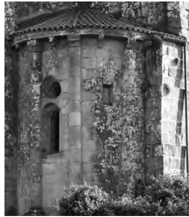
Ábside lateral derecho
