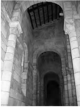
Nave lateral izq.
