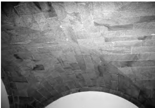
Cubierta de aristas.
