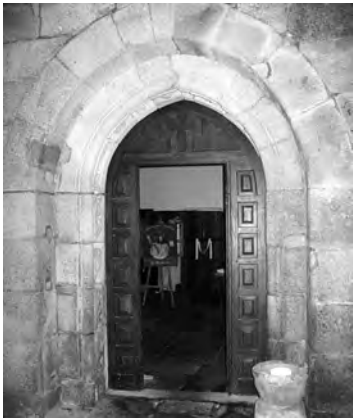
Puerta de acceso a la sacristía.
